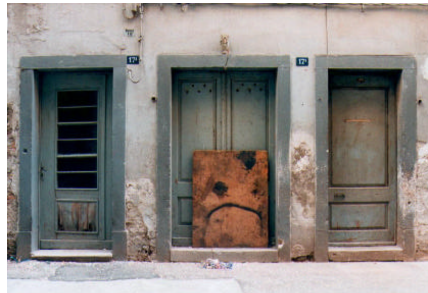
Cornici di tre aperture adiacenti semplicemente lavorate in pietra, con elementi di base sporgenti per l'apertura a sinistra.
