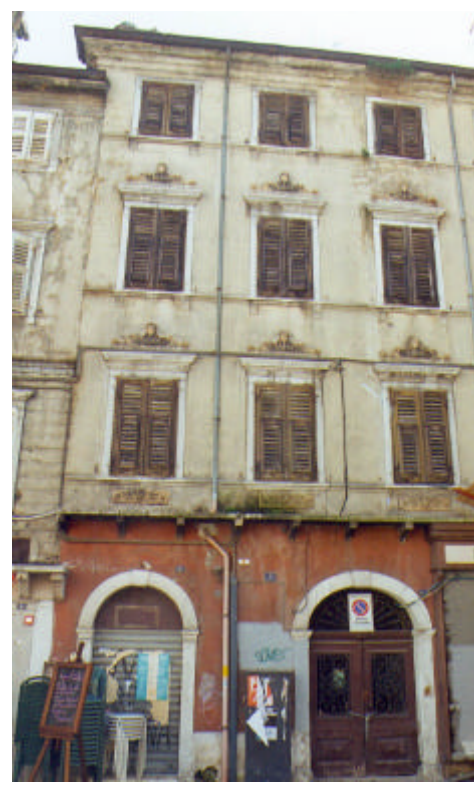
Rivestimento in intonaco liscio tinteggiato, ripartito da sottili cornici marcapiano in rilievo alla quota bancale dei vani finestra. Il trattamento cromatico è differenziato dal basamento.
