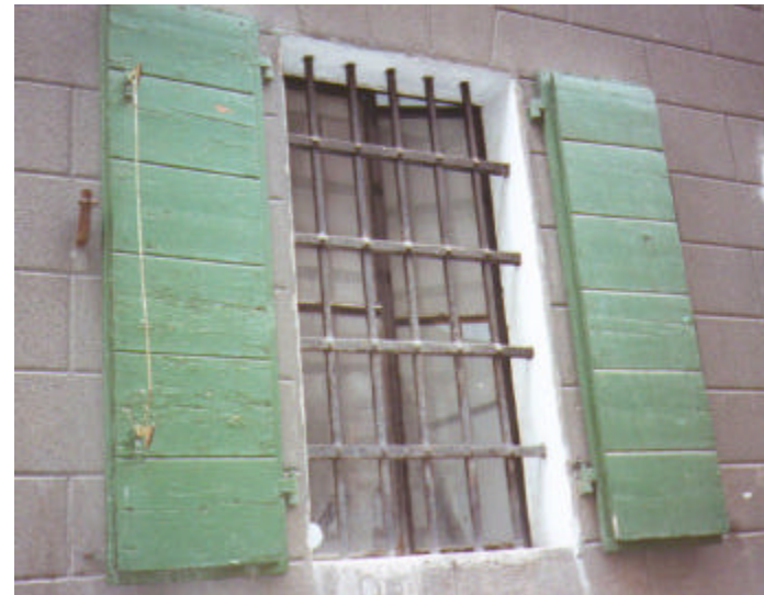
Portellone in legno verniciato; il tavolato interno è costituito da sei tavole per ciascuna anta.
