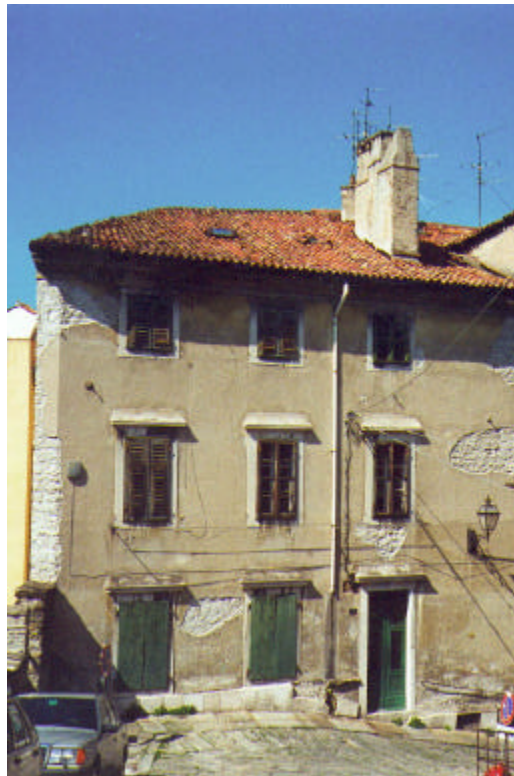
Rivestimento in intonaco liscio tinteggiato in continuità con il basamento.
