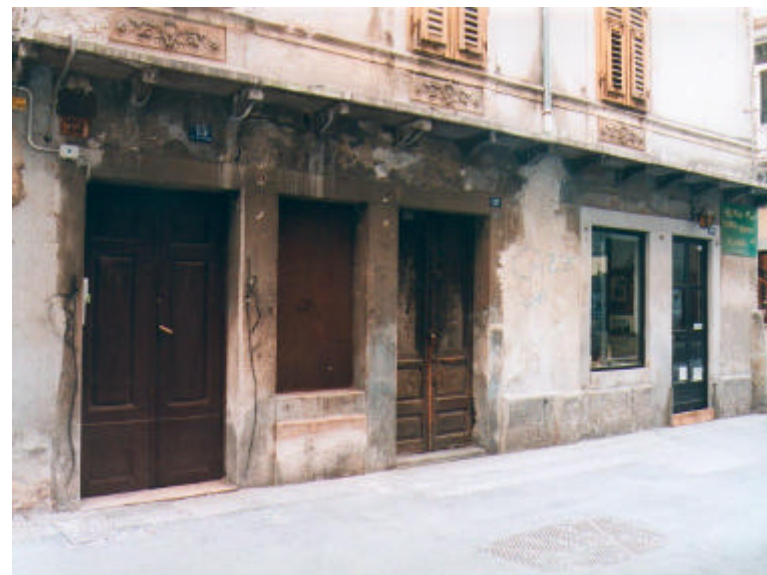
Cornice rettilinea in pietra che riquadra tre aperture affiancate, con architrave continuo realizzato con tre elementi lapidei e stipiti centrali comuni di dimensioni pari al doppio di quelli laterali. La zoccolatura si interrompe in corrispondenza degli stipiti.
