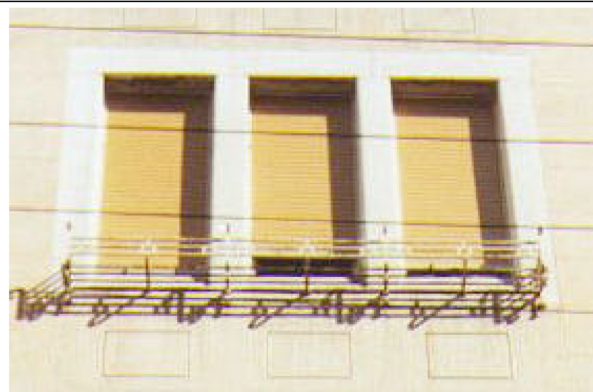
Cornice che delimita tre fori affiancati e separati da pilastri. La cornice rettilinea è a piani lisci a filo con il paramento esterno listato. Il lato inferiore delle aperture è dotato di portafioriera in ferro battuto verniciato. Sempre inferiormente ai vani, il paramento è decorato con un motivo e riquadri che definisce un pannello sottofinestra per ciascun vano.
