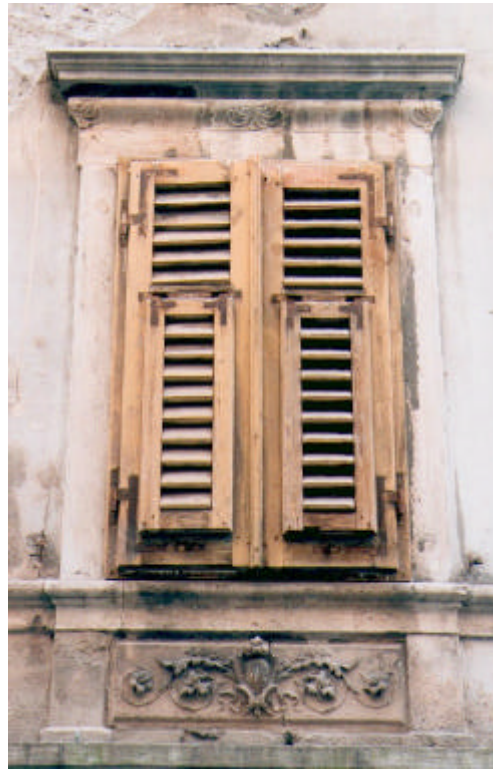
Persiana rettangolare in legno naturale a due ante bipartite. Il telaio esterno è sporgente dalla cornice della finestra e i battenti sono a questo sovrapposti.
