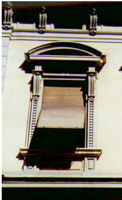
Persiana avvolgibile in legno naturale con sistema basculante.
