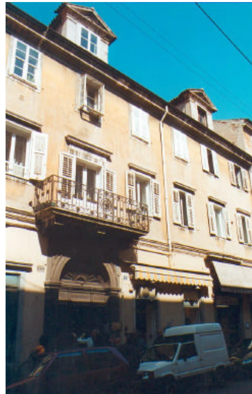
Rivestimento in intonaco liscio tinteggiato e separato dal rivestimento del basamento da una cornice marcapiano modanata. Il trattamento cromatico è differenziato da quello del basamento.
