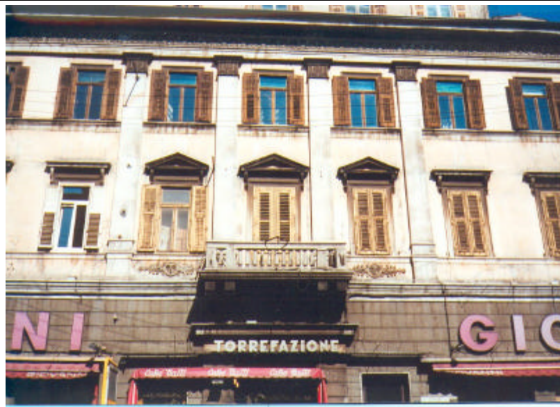
La facciata con rivestimento in intonaco liscio risulta tripartita nella parte centrale da un ordine gigante di lesene impostate su alti stilobati e coronate da capitelli compositi.
