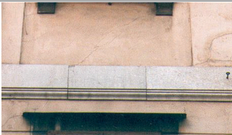
Cornice marcapiano lapidea a piani lisci e con bordi lievemente modanati, impostata alla quota dell'impalcato.
