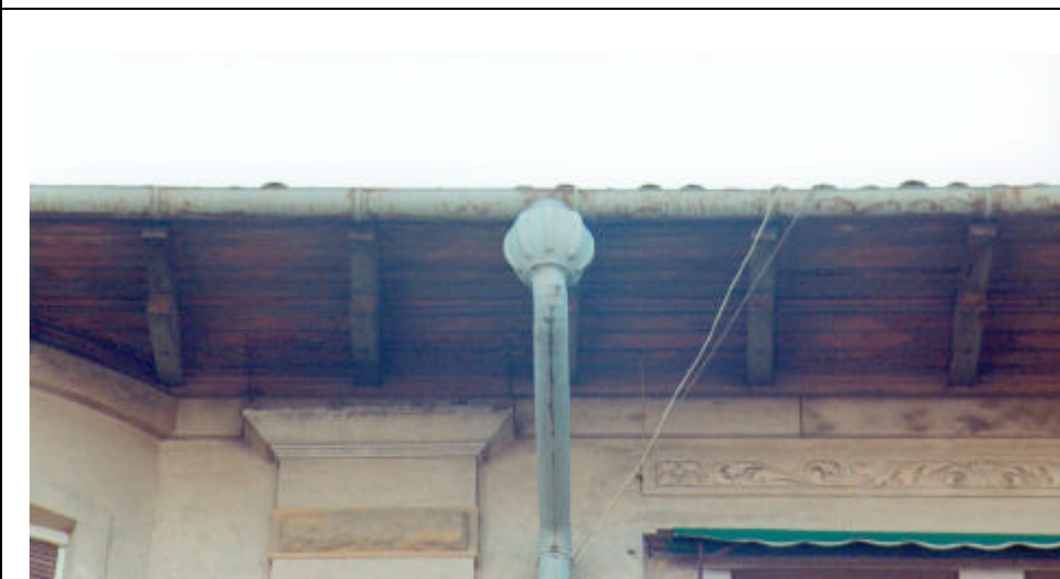
Dettaglio di cornice al rustico in cui sono chiaramente visibili gli elementi costituenti: mensola in forati e piastrelle sostenute da modiglioni in pietra (si noti l'elemento monolitico d'angolo), filari di mattoni sottomensola con spigoli arrotondati ed elementi sagomati a dentelli.
