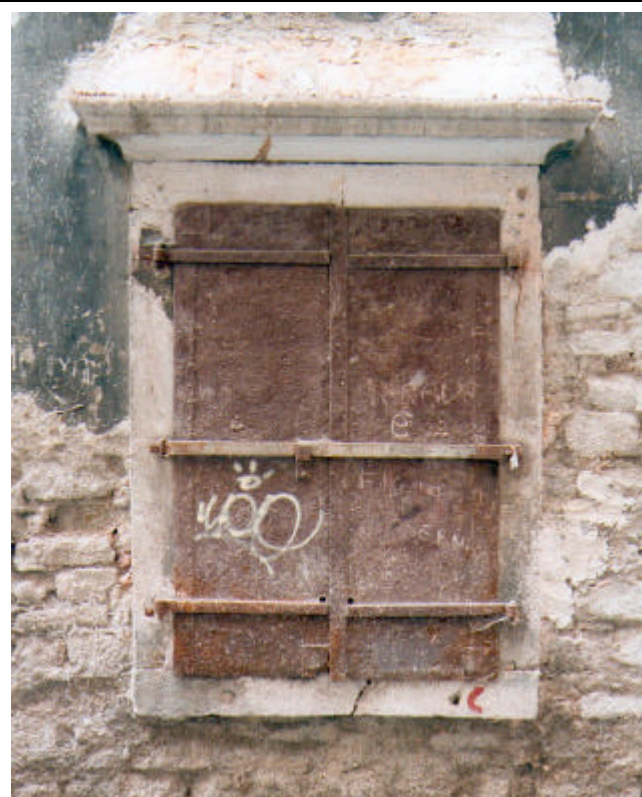
portellone in ferro a due battenti e due bandelle per anta, con sbarre di sicurezza esterne.
