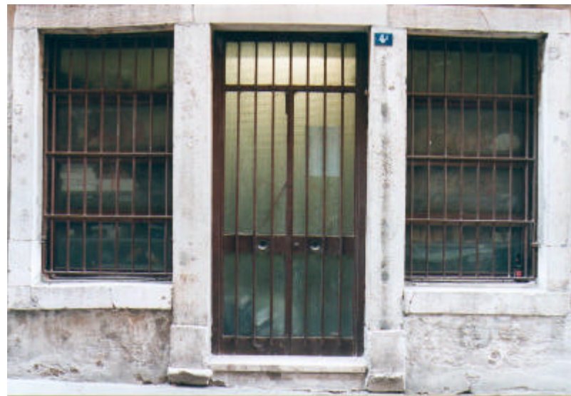
Cornice rettilinea in pietra che riquadra tre aperture affiancate, con stipiti centrali comuni ed architrave continuo realizzato con tre elementi lapidei. I piedritti centrali, che definiscono il vano d'accesso, hanno gli elementi di base sporgenti con modanatura nella parte inferiore.
