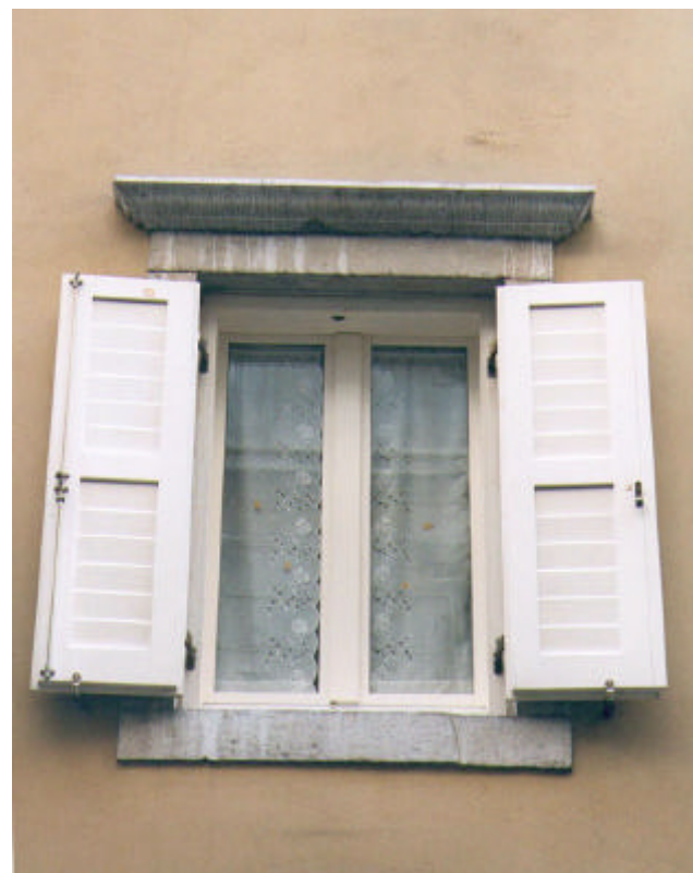
Cornice rettilinea a piani lisci in pietra naturale con cimasa in pietra modanata posta sull'architrave della cornice.
