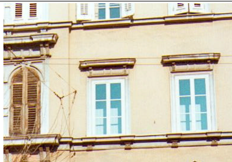
Fascia marcadavanzale in pietra a vista a piani lisci e con listelli perimetrali in risalto.
