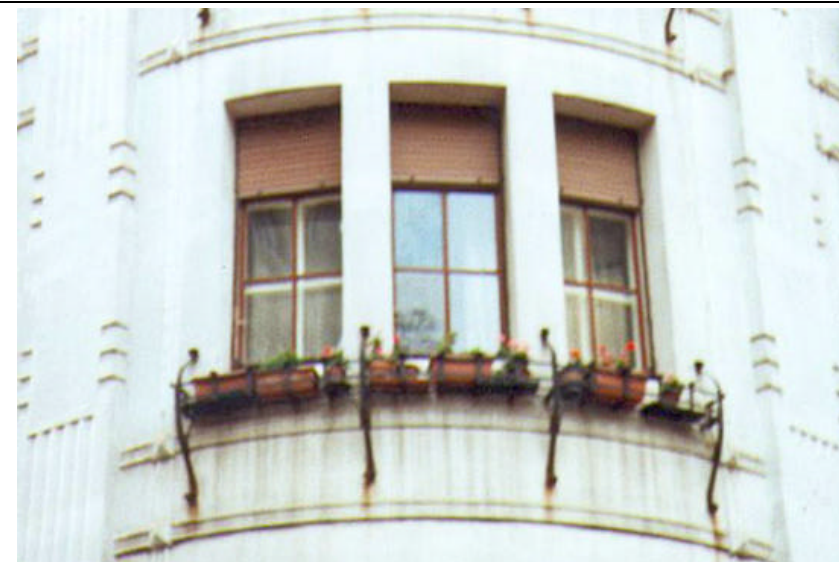
Cornice a piani lisci che riquadra un'apertura bipartita da un pilastro centrale. La cornice leggermente aggettante si inserisce nel disegno a riquadri della facciata con trattamenti superficiali ad imitazione della pietra. Il davanzale, anch'esso a piani lisci e lievemente aggettante, si innesta nella fascia marcapiano (marcadavanzale). Superiormente la cornice è sormontata da un pannello decorato a motivi floreali in rilievo.
