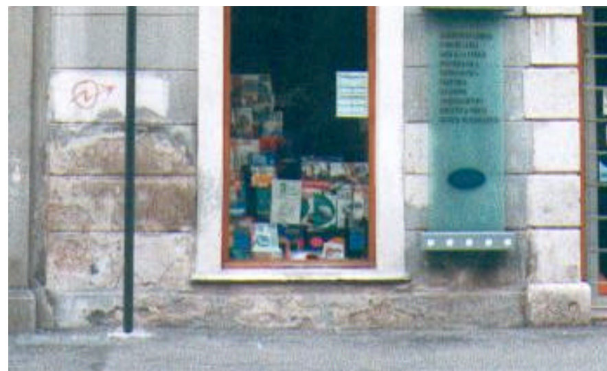
Zoccolatura a piani lisci in intonaco a forte spessore di circa cm 40 di altezza, inserita tra i piedritti degli stipiti delle aperture a piano terra realizzati in pietra.
