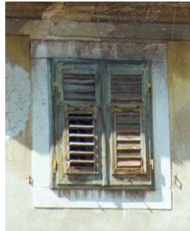
Persiana rettangolare a due ante bipartite in legno verniciato. La manovrabilità delle lamelle consente la regolazione differente per ciascuno sportello.
