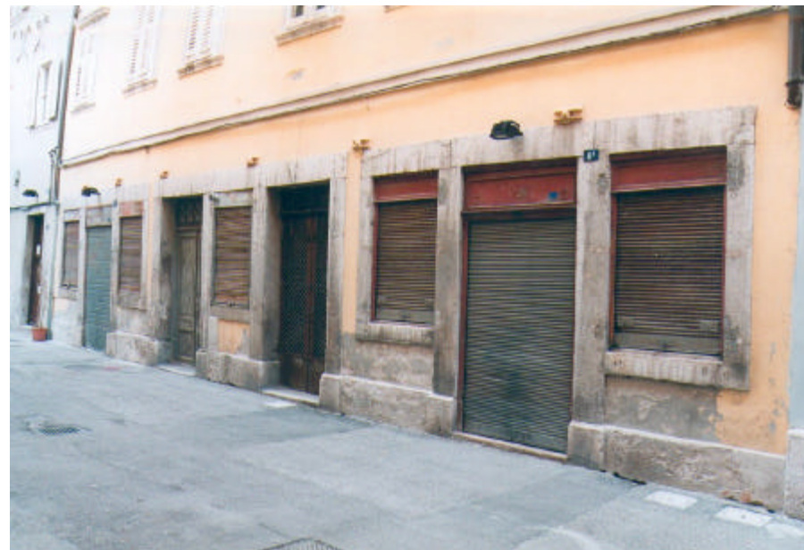
Saracinesche in ferro per porte e finestre architravate al piano terra.
