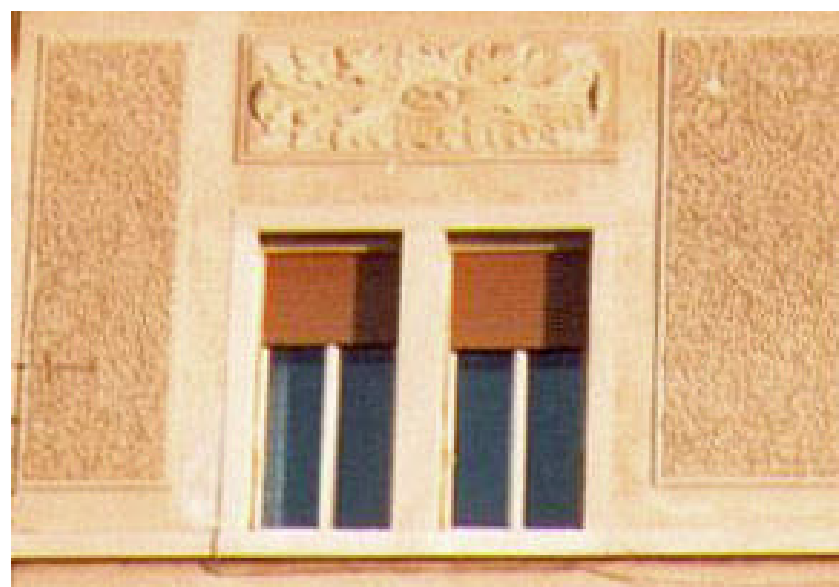
Cornice a piani lisci che riquadra un'apertura bipartita da un pilastro centrale. La cornice leggermente aggettante si inserisce nel disegno a riquadri della facciata con trattamenti superficiali ad imitazione della pietra. Il davanzale, anch'esso a piani lisci e lievemente aggettante, si innesta nella fascia marcapiano (marcadavanzale). Superiormente la cornice è sormontata da un pannello decorato a motivi floreali in rilievo.
