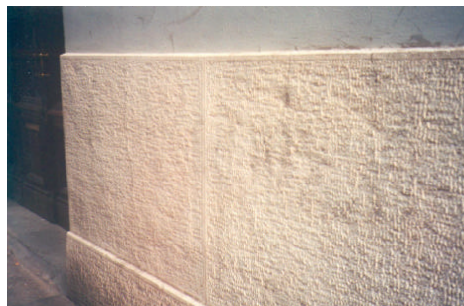
Zoccolatura rettilinea con elemento di base in rilievo, realizzata in blocchi di pietra chiara lavorata alla martellina con nastro perimetrale liscio.
