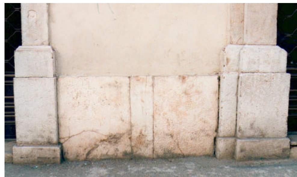
Zoccolatura rettilinea in lastre di pietra chiara ; in prossimità delle aperture la zoccolatura è sagomata in maniera più ricca e forma la base per gli stipiti.
