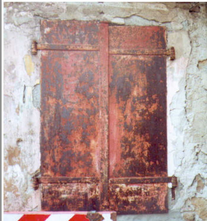
Portellone in ferro a due battenti e due bandelle per anta.
