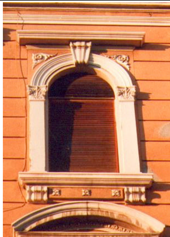
Persiana avvolgibile in legno naturale. La persiana risulta suddivisa in due parti: una semicircolare fissa e l'altra rettangolare avvolgibile con sistema basculante
