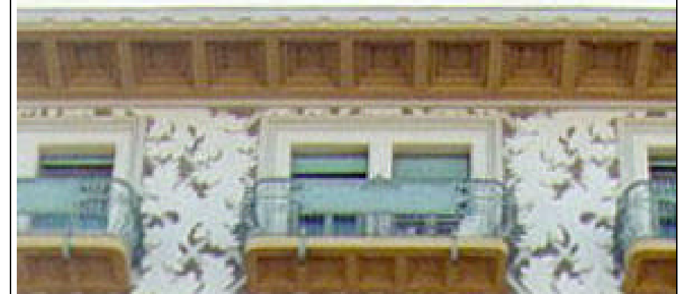
Cornicione monocromatico a sbalzo con decorazione a cassettoni all'intradosso riproposta anche negli sporti dei balconi.
