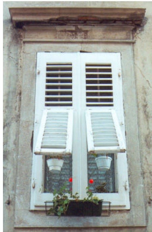
Persiana rettangolare in legno verniciato a due ante bipartite; gli sportelli inferiori sono in posizione di apertura.
