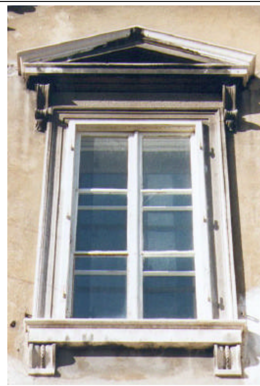
Cornice in pietra modanata con cimasa a timpano triangolare su mensole a voluta. Il davanzale lapideo modanato poggia su mensole a voluta con decoro centrale.
