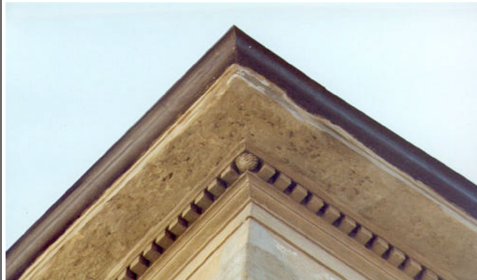
Dettaglio di cornice monocromatica in cui sono chiaramente visibili tutte le modanature, in particolare i dentelli con la pigna d'angolo secondo la tradizione del coronamento classico greco. Si noti il trattamento dell'intonaco ad imitazione della pietra.
