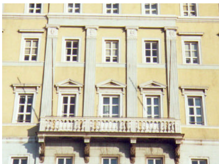
Fondo in intonaco liscio con avancorpo centrale tripartito per due piani da un ordine gigante di lesene scanalate impostate su alti stilobati compresi nell'aggetto del poggolo centrale. La trabeazione si innesta nella cornice marcapiano modanata dell'ultimo livello. Altre cornici marcapiano, impostate alla base delle finestre, scandiscono la superficie della facciata.
