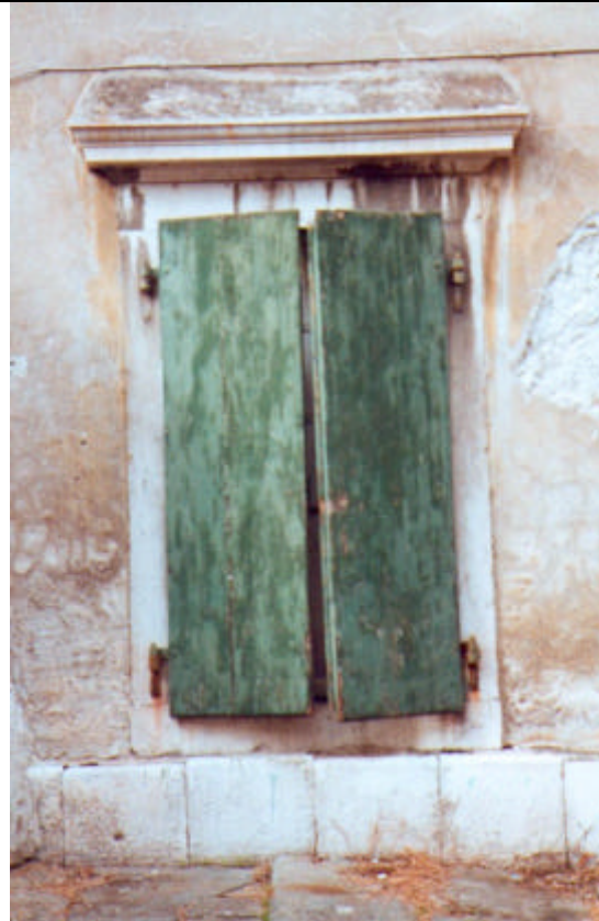
Portellone in legno verniciato, sostenuto da un sistema di due cerniere per ogni anta.
