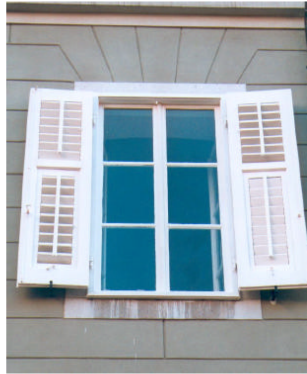
Persiana rettangolare a due ante in legno verniciato bipartite con telaio fisso sporgente dalla cornice della finestra.
