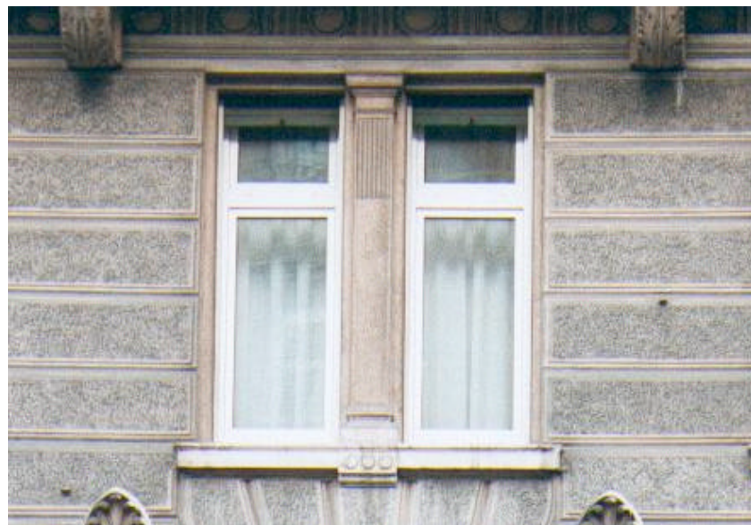
Cornice monocromatica di un'apertura bipartita con pilastro dorico centrale. La cornice a piani lisci, sottoposta rispetto al piano del bugnato rustico del paramento e del pilastro, riquadra ciascun foro su tre lati. La parte inferiore dell'apertura è delimitata da un davanzale rettilineo a piani lisci con gocciolatoio e con elemento decorato in lieve aggetto in corrispondenza del pilastro centrale.
