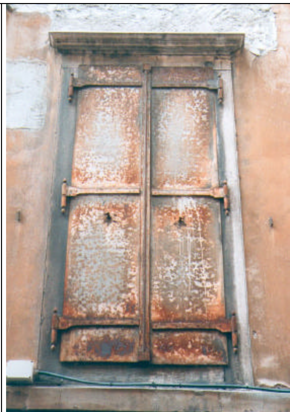
portellone in ferro a due battenti e tre bandelle per anta.
