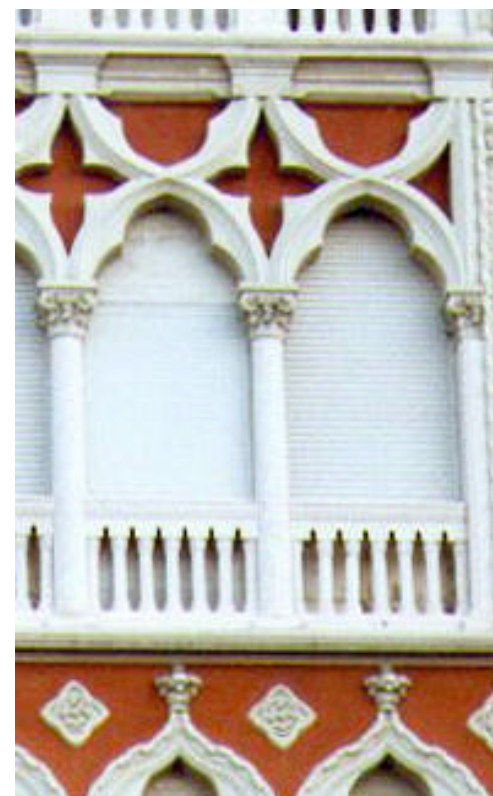
Persiana avvolgibile in legno verniciato. Nell'apertura di destra la parte superiore della persiana è fissa.
