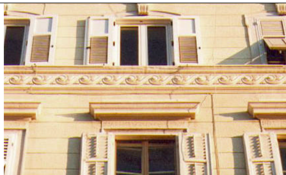
Fascia marcapiano definita da due cornici in rilievo e da un decoro centrale a volute. Le due cornici sono poste rispettivamente alla quota dell'impalcato ed alla quota bancale delle finestre.
