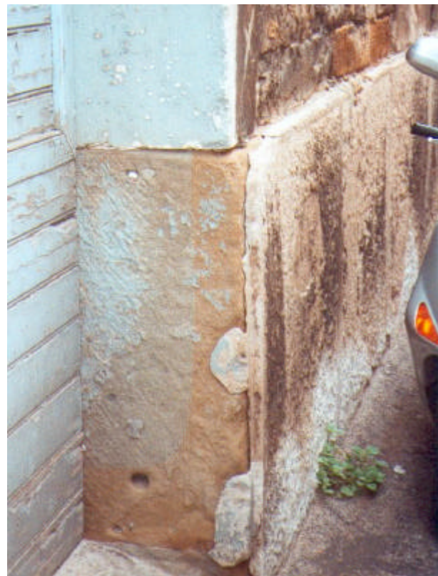
Zoccolatura a riquadri di circa cm 80 di altezza, realizzata in intonaco con finitura ad imitazione della pietra.
