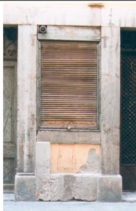
Saracinesca in ferro con mostra e pannello superiore in legno verniciato.
