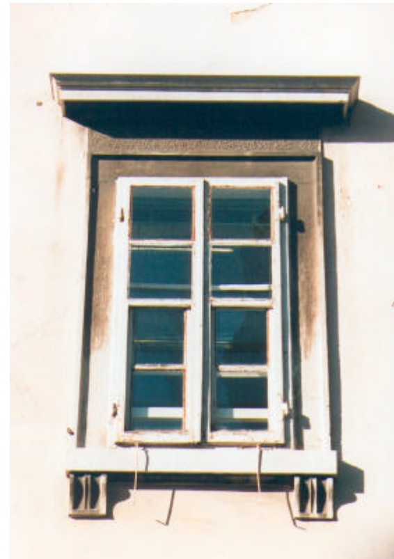
Cornice in pietra modanata con cimasa rettilinea raccordata alla cornice con una fascia lavorata al rustico. Il davanzale lapideo modanato poggia su mensole a voluta con decoro centrale.
