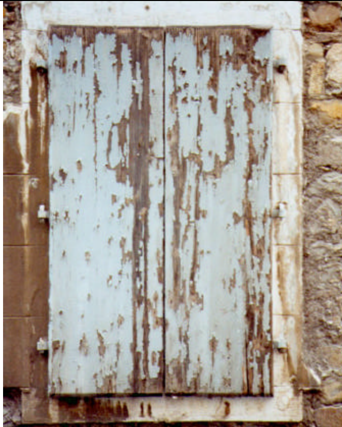
Portellone in legno verniciato, sostenuto da un sistema di tre cerniere per ciascuna anta.
