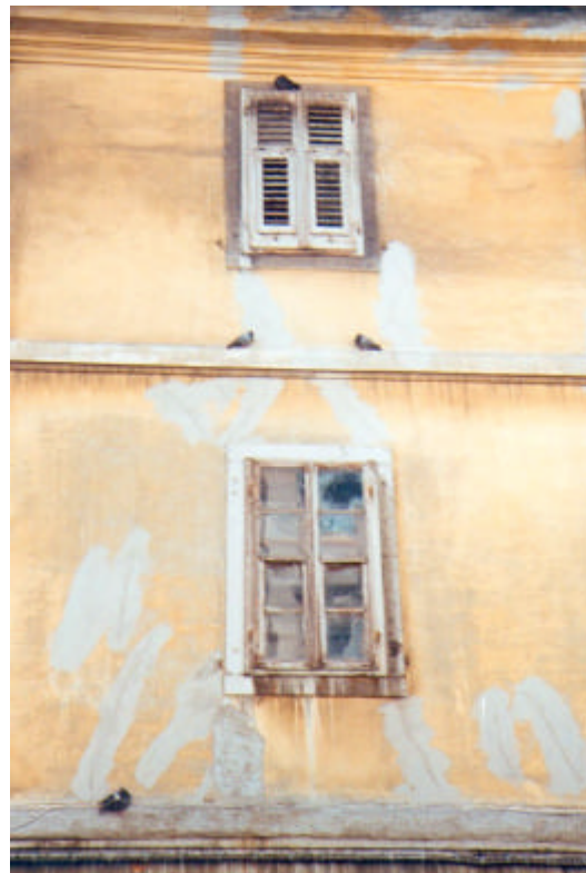
Rivestimento in intonaco liscio tinteggiato e ripartito da una cornice marcapiano. Il trattamento cromatico risulta differenziato da quello del basamento.
