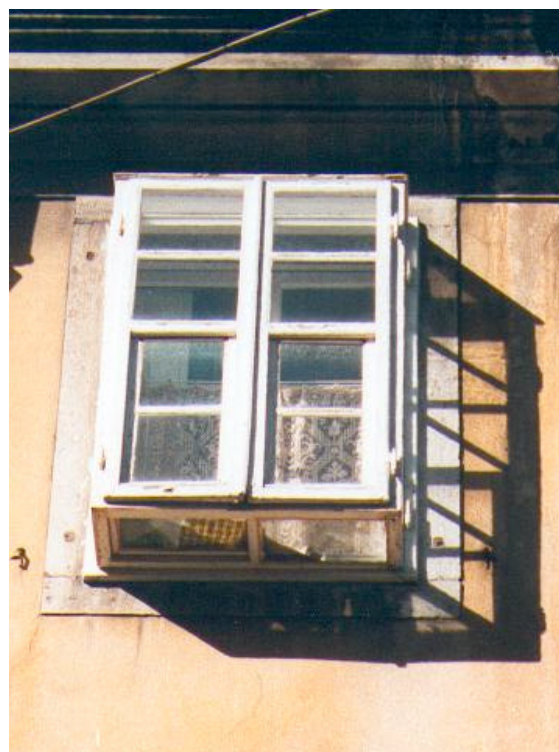
Finestra a sburto con pannelli verticali fissi e mobili quadripartiti. La parte anteriore è apribile sia completamente verso l'esterno sia a coulisse per la metà inferiore.
