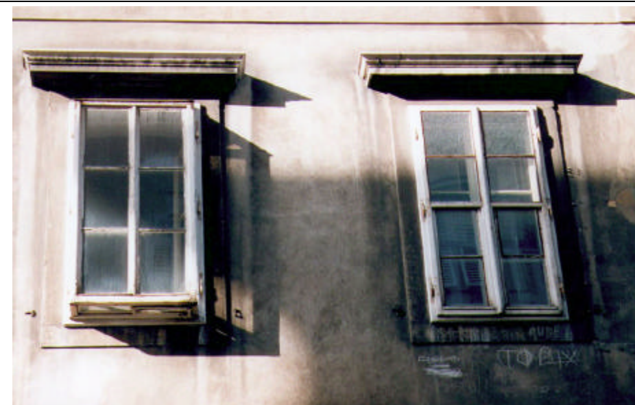
Finestra a "sburto" con ante verticali tripartite. Le ante mobili sono apribili verso l'interno. Una seconda apertura è realizzata con l'antina scorrevole del pannello vetrato orizzontale inferiore. Il serramento contiguo nel piano della facciata pur avendo la stessa ripartizione, non è aggettante dalla facciata.
