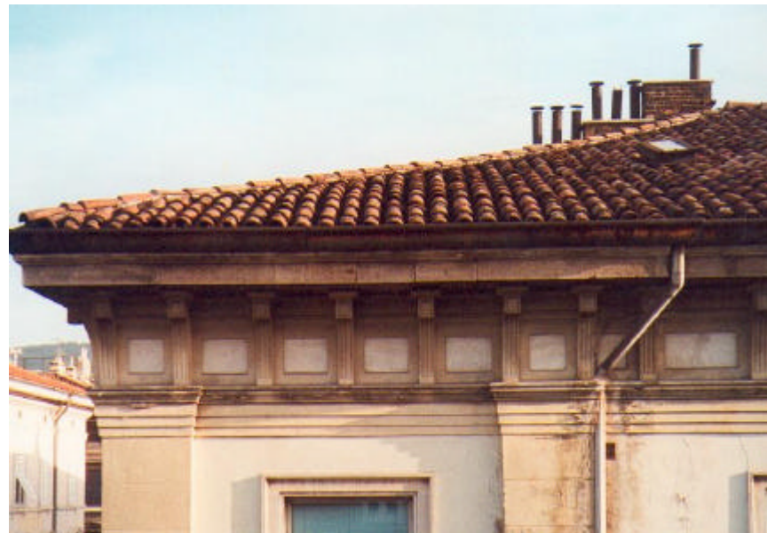
Cornicione bicromatico decorato alla maniera della trabeazione dorica, "metope" e "triglifi", sono richiamati dalle semplici riquadrature e dai modiglioni.
