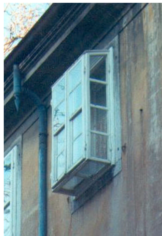
Finestra "a sburto" con pannelli vetrati laterali fissi quadripartiti. I battenti anteriori, anch'essi quadripartiti e apribili verso l'esterno, hanno le antine inferiori scorrevoli a coulisse.
