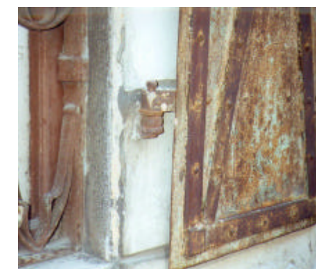
Particolare della cerniera con il perno infisso nella cornice in pietra e vista dell'interno del portellone con gli irrigidimenti in piattine di ferro chiodate
