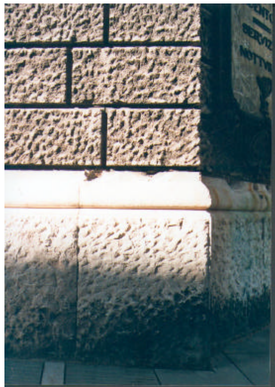
Zoccolatura in lastroni di pietra chiara lavorata al rustico con toro di raccordo al paramento bugnato del basamento.
