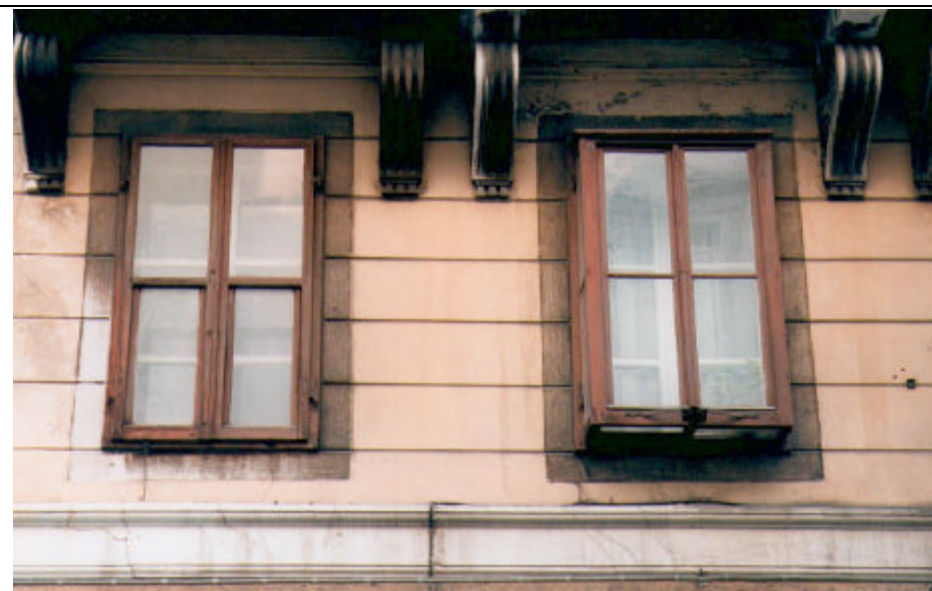
Infisso a "sburto" con ante bipartite. I battenti anteriori sono apribili verso l'interno sovrapponendosi alle ante fisse laterali. Si noti che anche il serramento contiguo nel piano della facciata non è del tipo a "sburto".
