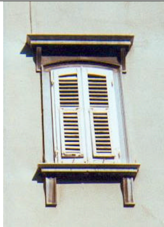
Cornice ad arco ribassato modanata con elemento di raccordo alla cimasa trattato al rustico. La cimasa ed il davanzale modanati poggiano su mensole a voluta.
