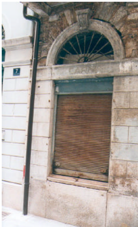
Saracinesca in ferro per una finestra al piano terra. Il sopraluce circolare è protetto da una rosta in ferro verniciato
