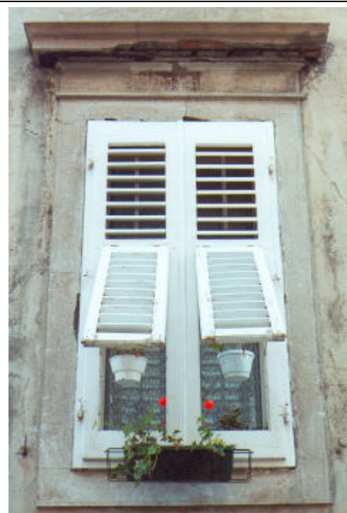
Cornice rettilinea in pietra naturale lavorata a martellina con nastrino liscio perimetrale. La cimasa modanata, in lastre di pietra su ossatura metallica, è raccordata alla cornice da una fascia lavorata al rustico compresa tra due listelli orizzontali
