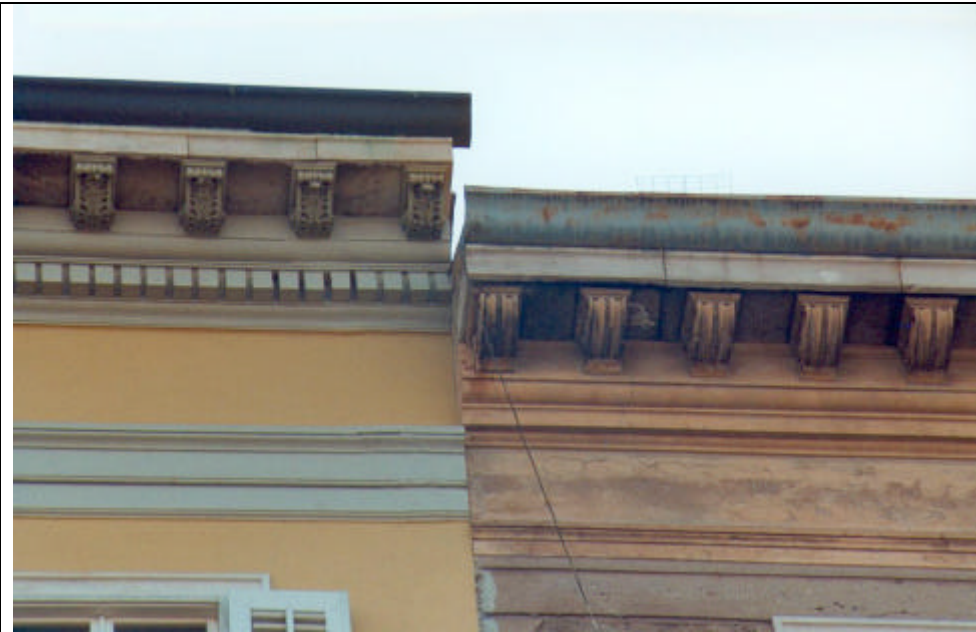
Cornicioni con fasce sottocornice modanate. La sporgenza delle lastre sottocornice è assicurata da una serie ravvicinata di modiglioni.
